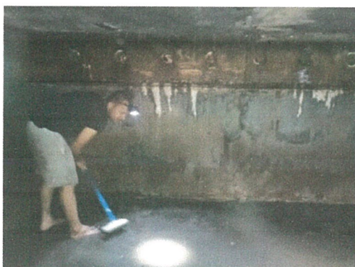
รูปภาพที่ 2.70 การล้างถังเก็บน้ำ
