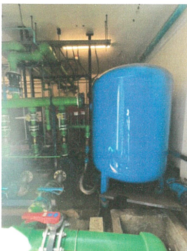
รูปภาพที่ 2.43 ถังเก็บน้ำโครงการ
