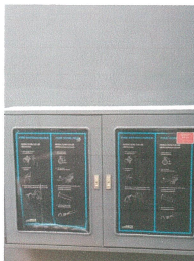
รูปภาพที่ 2.21 ป้ายแสดงวิธีการใช้อุปกรณ์ถังดับเพลิง
