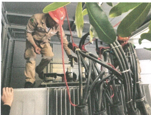
รูปภาพที่ 2.68 การตรวจสอบหม้อแปลงไฟฟ้า
